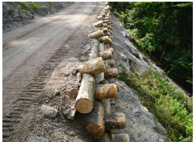
Der Holzkasten besitzt den Vorteil, dass die Massnahme vergleichsweise kostengünstig ist, der Hang längerfristig gesichert und die Strasse wieder benutzbar wird. Die Arbeiten sollen grundsätzlich von Forst & Dienste Laufenburg-Gansingen ausgeführt werden. Auf Grund des steilen Geländes muss zusätzlich ein Spezialist mit einem Schreitbagger beigezogen werden.
